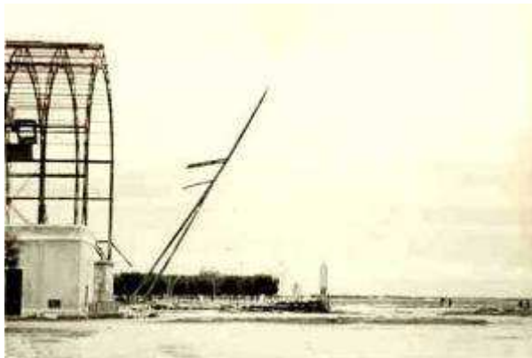
Aeroporto di Grottaglie – Demolizione di un Hangar per dirigibili della 1a Guerra Mondiale
