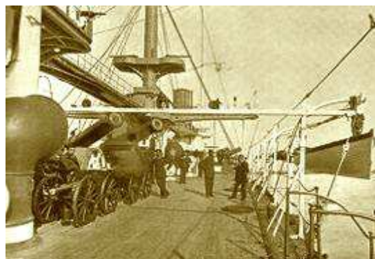
Il ponte di coperta del Di Lauria
