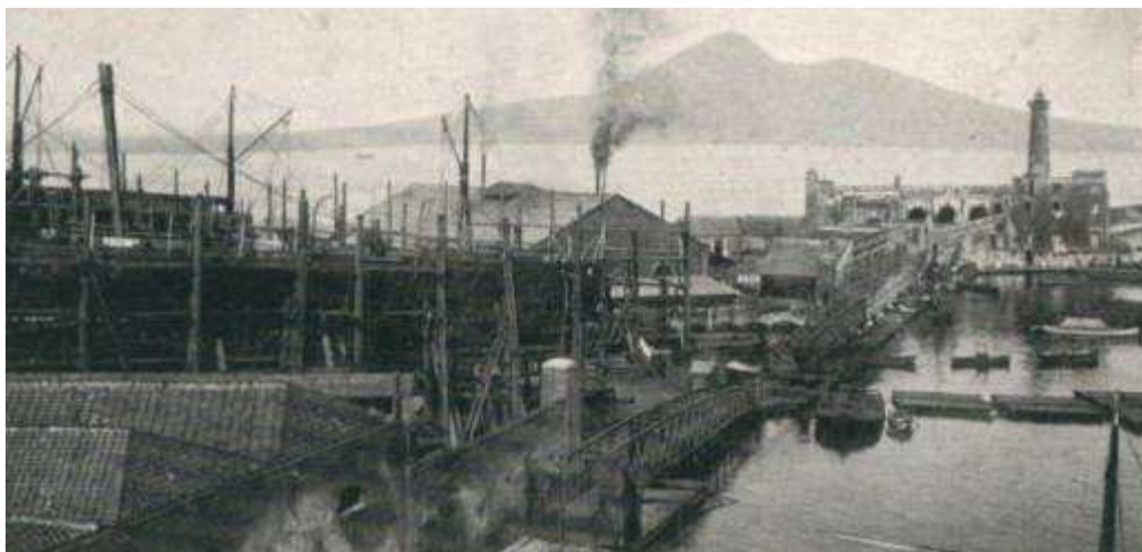
Vista del cantiere navale di Castellammare di Stabia
